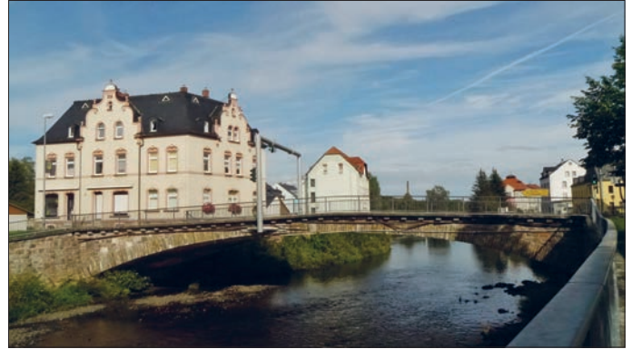
Die Zschopaubrücke vor dem Abriss Aufnahme 24. August 2020
